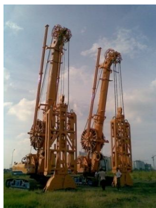
Máy thi công cọc Barret
