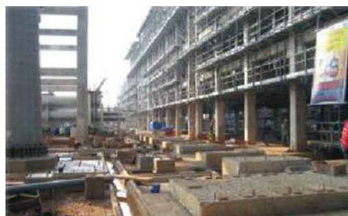
Hệ thống giá đỡ ống và móng thiết bị - Nhà máy lọc dầu Dung Quất
