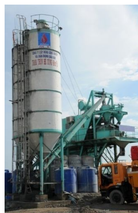
Trạm trộn bê tông 60m 3 /h
